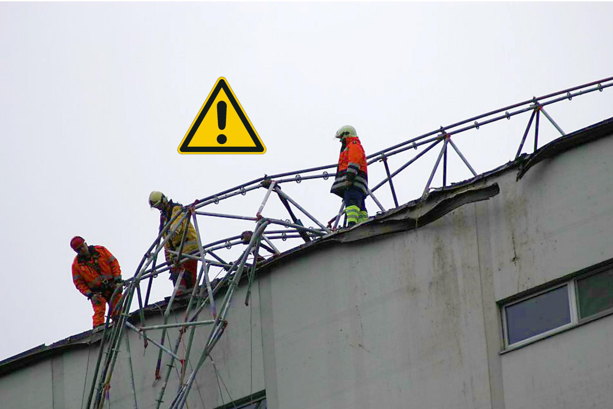
*Gefahreninventar: Sturmböen, labiles Bauteil, Nässe, potenzielle Sturzhöhe 40m (Bild eines Passanten)*
