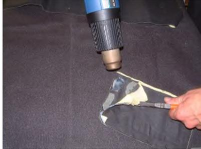
Mit der Zange abziehen. Unter Zug weiter erhitzen und so den defekten Streifen lösen.
